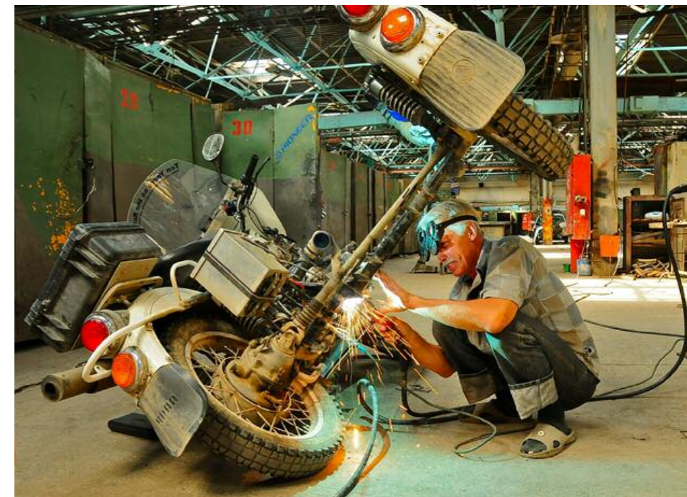
Die mehrfach notdürftig geflickte Beiwagenachse des Ural-Gespans genoss im Werk von Irbit endlich fachgerechte Behandlung
